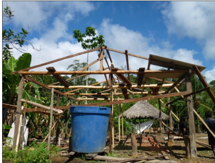
Foto 140. Proyecto construcción de 13 viviendas Resguardo Santa Rosa de Ijuá
