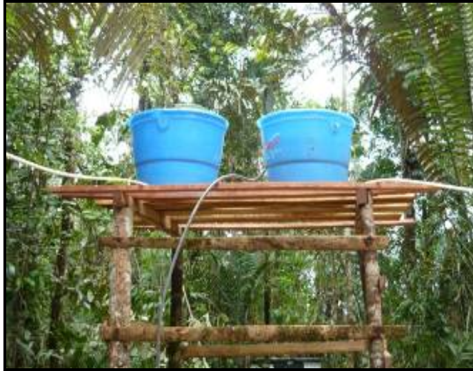
Foto 12. Disposición de tanques de agua en campamentos volantes
