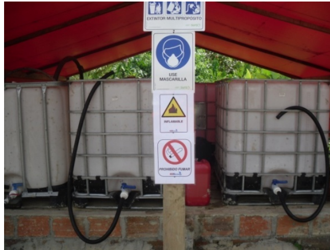
Foto 35. Señalización de riesgos en sitio de almacenamiento de combustible, Sub-base
