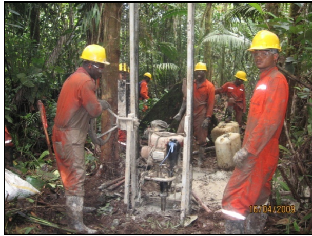
Foto 18. Torre-Punzón perforando un pozo
