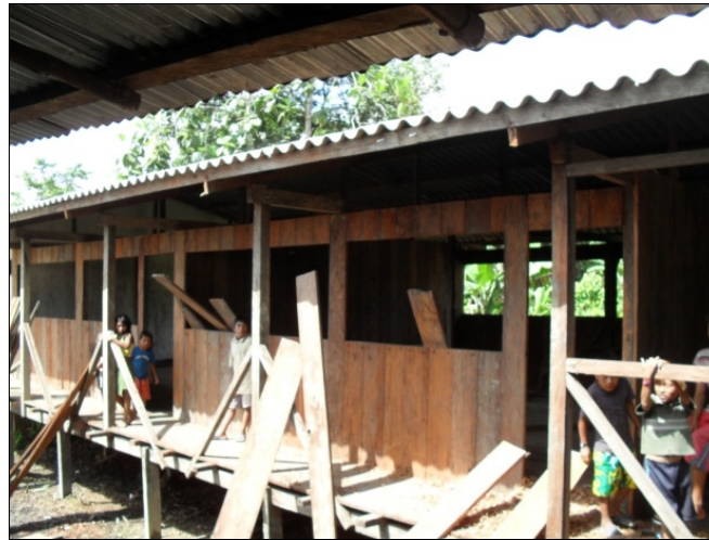
Foto 135. Proyecto Construcción de 5 aulas en madera
