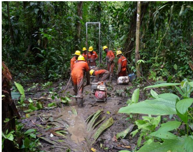
Foto 8. Cuadrilla de taladro empleando Torre Yacro, y agua como fluido de perforación
