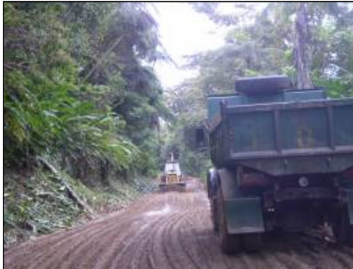
Foto 149. Mejoramiento de la vía, desde la vereda Campoalegre hasta La Punta
