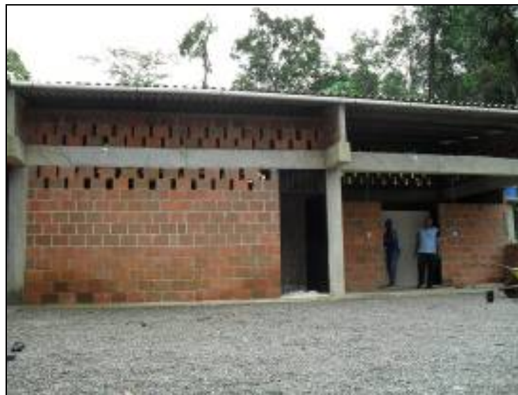
Foto 89. Proyecto construcción escuela Rosa Zárate, en la vereda Chucheros, del C. C. Bahía Málaga
