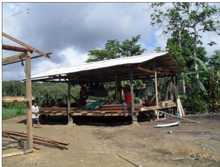
Foto 141. Proyecto construcción de 13 viviendas Resguardo Santa Rosa de Ijuá
