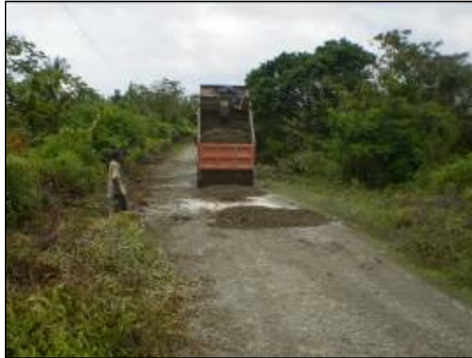
Foto 94. Proyecto de mejoramiento de la vía de San Isidro a La Colonia
