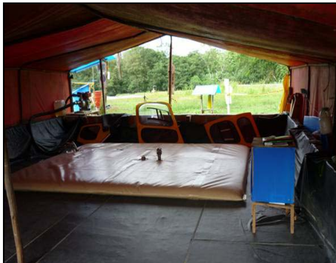
Foto 3. Blader para almacenamiento de JP-A1. Sub-base Panamacito
