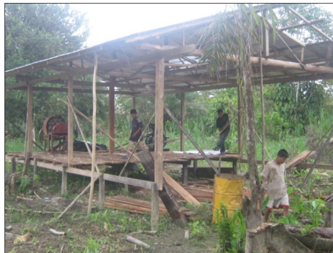
Foto 127. Proyecto mantenimiento de un trapiche y construcción de caseta de 12x6m para su instalación
