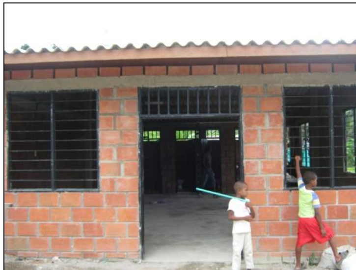
Foto 92. Proyecto construcción de la Caseta Comunitaria Vereda Miramar
