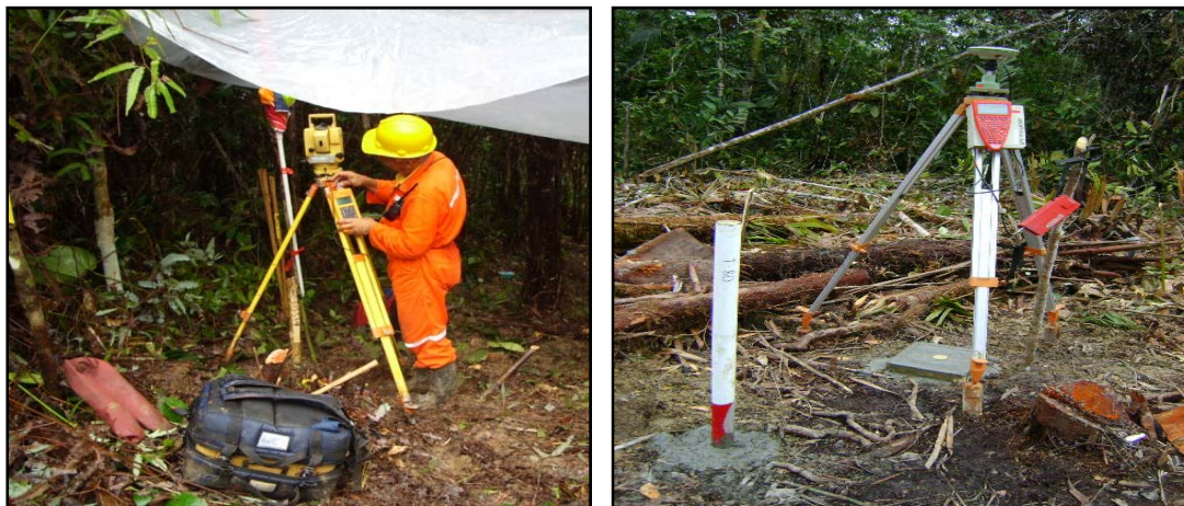
Figura 3. Equipo de nivelación de línea – Equipo de GPS en helipuerto
