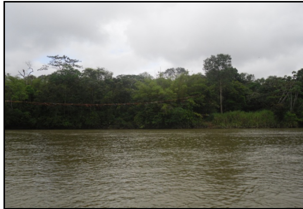
Foto 21. Cruce de cable sobre el Río Calima
