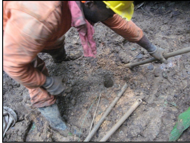
Foto 20. Cargado de Pozo
