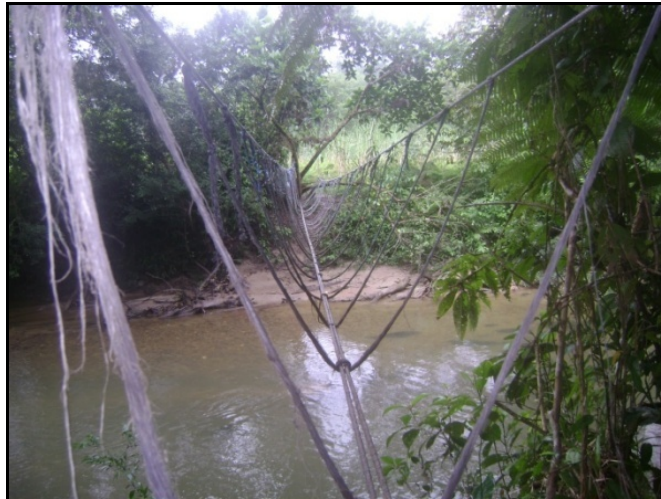
Foto 27. Paso sobre Cuerpo de Agua Construido en Manila
