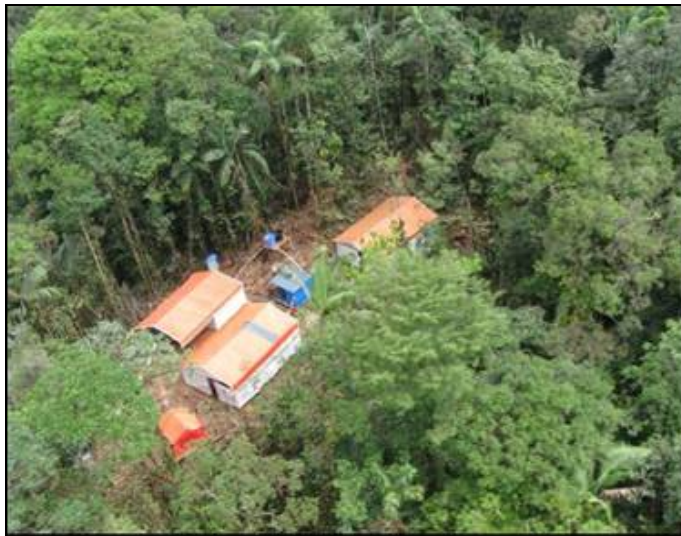
Foto 11. Ubicación, diseño y construcción de campamentos volantes en la línea
