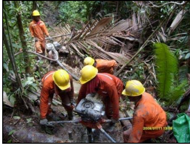
Foto 16. Perforación con taladro portátil y sistema de agua
