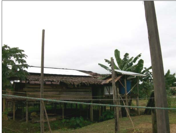
Foto 128. Mejoramiento de vivienda para 8 familias
