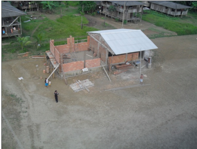
Foto 132. Construcción de un aula escolar de 7x6.5 m2 para la Institución Educativa la Unión
