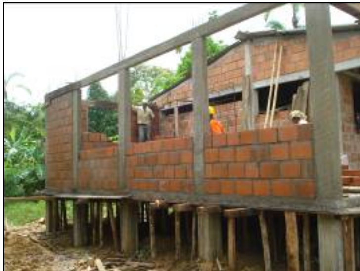
Foto 97. Proyecto construcción, adecuación y dotación de comedor escolar Guadual
