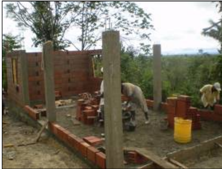
Foto 98. Proyecto construcción, adecuación y dotación de comedor escolar Las Brisas
