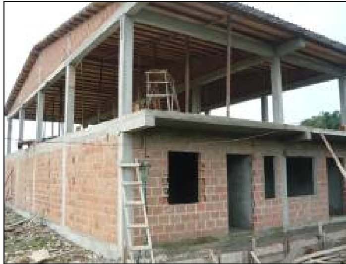
Foto 111. Proyecto construcción de la Sede del Consejo de ACADESAN en Istmina
