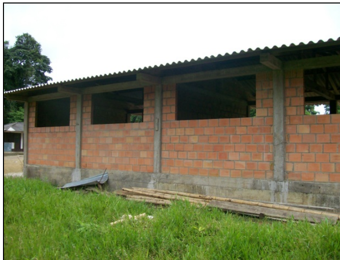
Foto 130. Mejoramiento de la infraestructura escolar Río Pichimá (I)
