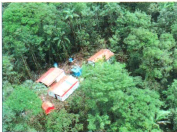
Foto 8. Ubicación, diseño y construcción de campamentos volantes en la línea
