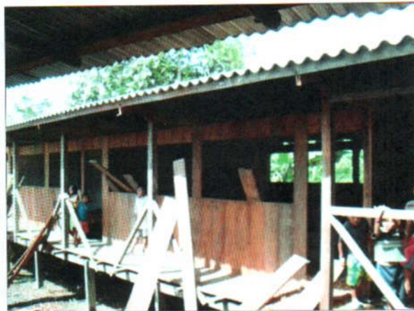
Foto 83. Proyecto Construcción de 5 aulas en madera
