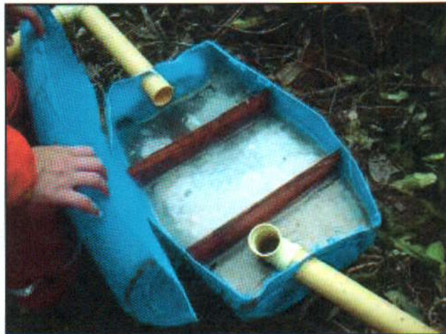
Foto 47. Sistema de Trampa-Grasa. Campamentos volantes
