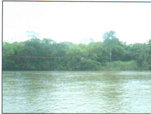
Foto 17. Cruce de cable sobre el Río Calima
