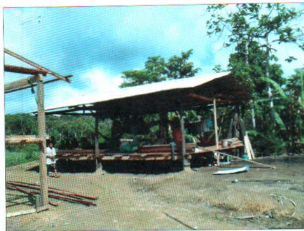
Foto 86. Proyecto construcción de 13 viviendas Resguardo Santa Rosa de Ijuá
