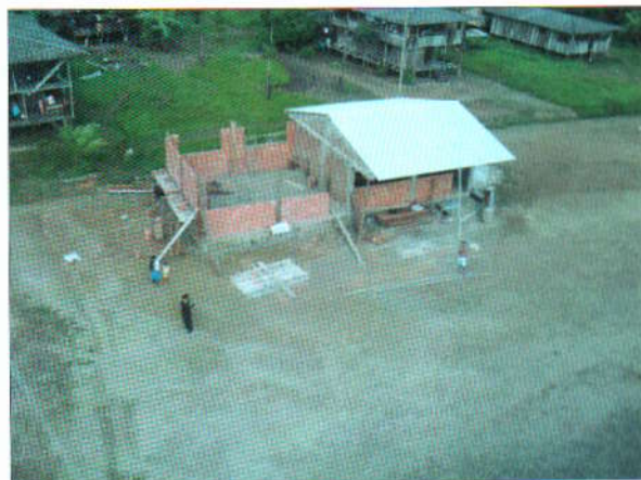
Foto 82 Construcción de un aula escolar de 7x6.5 m2 para la Institución Educativa la Unión
