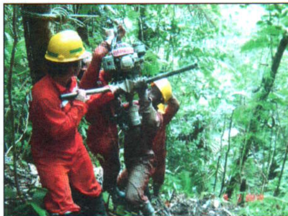
Foto 24. Facilidades con Poleas y Cuerdas para Transporte de Equipos en Terrenos Inclinados
