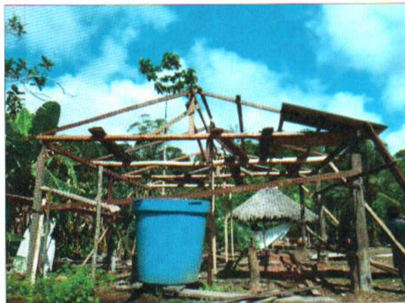
Foto 85. Proyecto construcción de 13 viviendas Resguardo Santa Rosa de Ijuá
