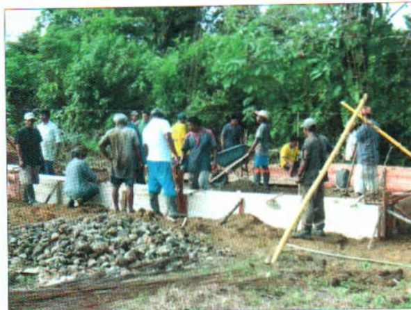
Foto 88. Proyecto compra de materiales de construcción para la Institución educativa Genaro Opúa
