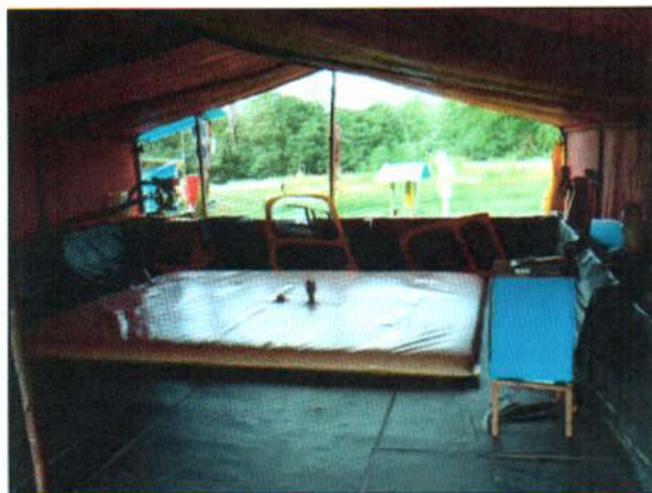
Foto 3. Blader para almacenamiento de JP-A1. Sub-base Panamacito
