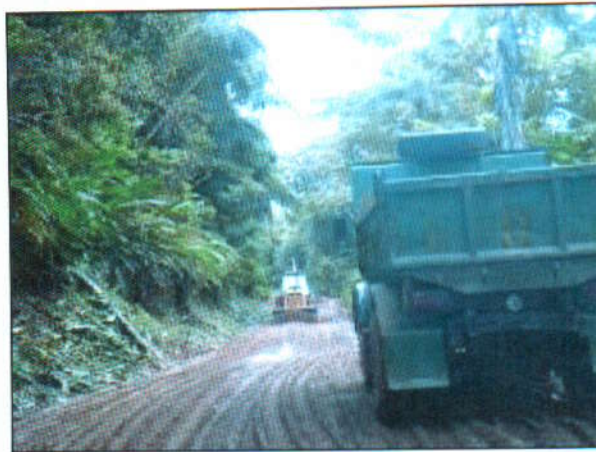
Foto 89. Mejoramiento de la vía, desde la vereda Campoalegre hasta La Punta, municipio Calima-Darién (Valle del Cauca)
