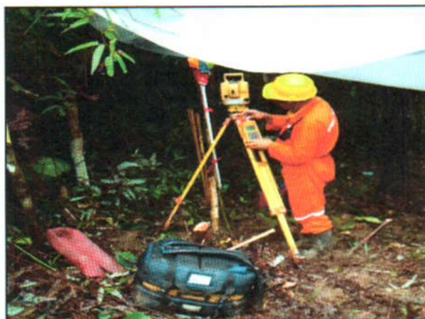
Foto 9. Equipo de topografía en nivelación de línea, Topcon GTS 211
