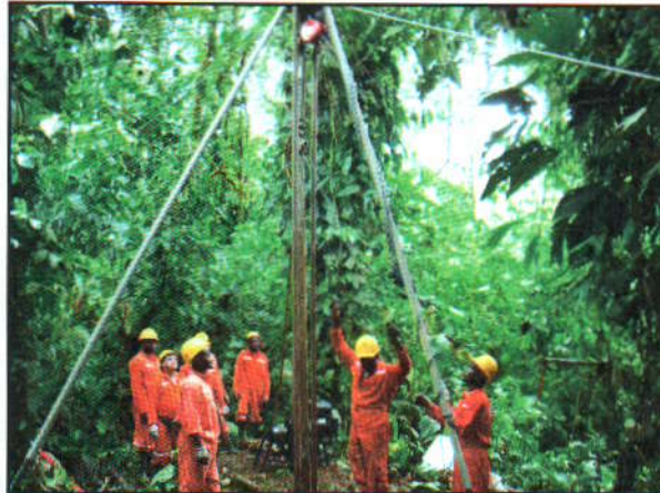
Foto 14. Torre-Punzón perforando un pozo
