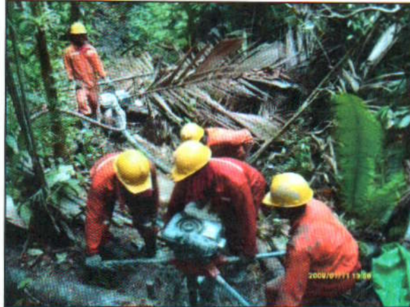
Foto 12. Perforación con taladro portátil y sistema de agua
