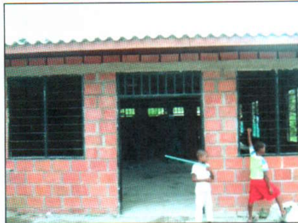
Foto 73. Proyecto construcción de la Caseta Comunitaria Vereda Miramar
