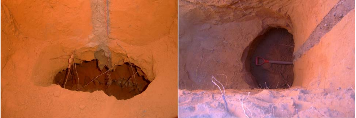
Figura 30 Excavación de un pozo detonado (foto cortesía de Geokinetics)
