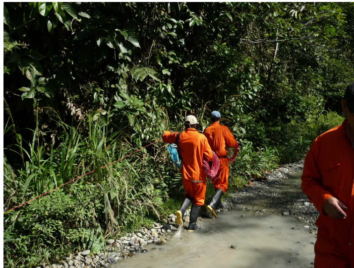
Fig 7. Tendido de cable sobre la vía Opogodó – San Lorenzo.
