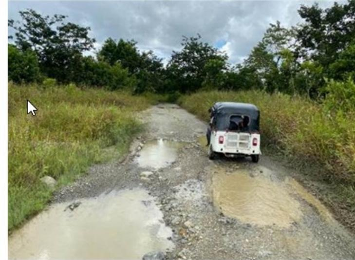
Ruta 1: Via en afirmado, tramo no transitable con poca visibilidad, pozos llenos de agua y segregacion de material
