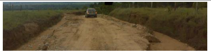
FOTO 35 Arrastre de material de la vía hacia predios cercanos y los drenajes y cañadas.
