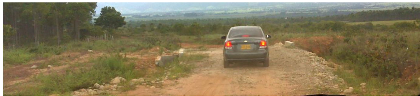
FOTO 36: Arrastre de material de la vía hacia predios cercanos y los drenajes y cañadas. Alcantarilla que evacúa las aguas en la vía pero que contribuye a drenar los terrenos y predios cercanos.
