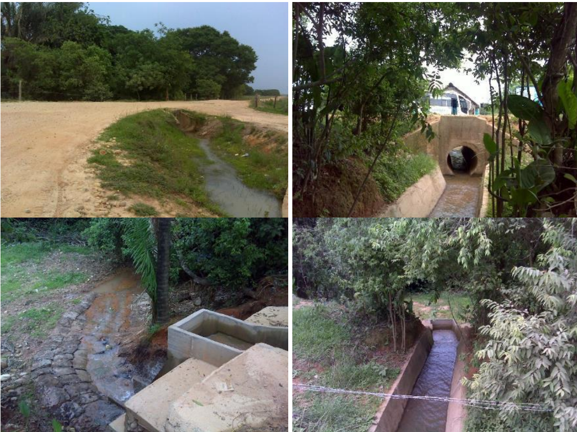
Foto 14: Obra de ingeniería (Box culvert, canaleta en cemento y dissipador de energía) realizada para drenar las aguas de una zona de préstamo hacia un caño natural.
