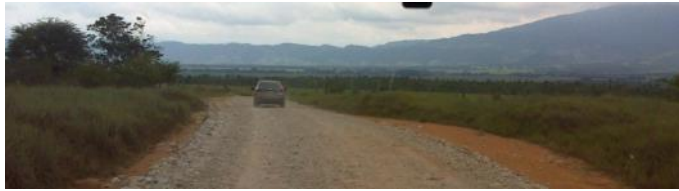
FOTO 28: Material sub-base granular y crudo esparcido a lo largo de la vía vereda Brisas del Llano.
