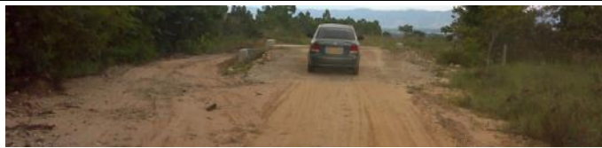
FOTO 34 Arrastre de material de la vía hacia predios cercanos y los drenajes y cañadas. Alcantarilla que evacúa las aguas en la vía pero que contribuye a drenar los terrenos y predios cercanos.
