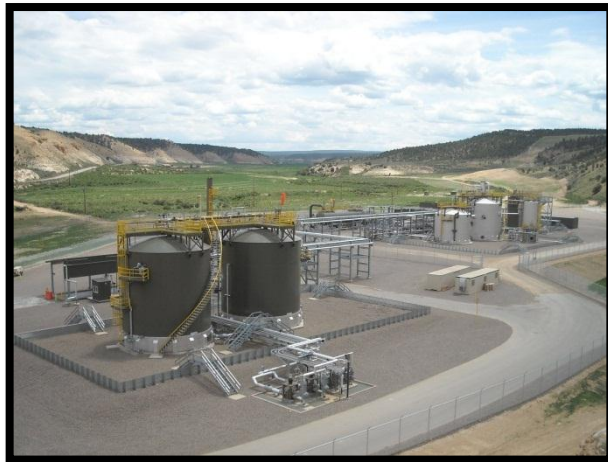
Sistema de distribución de agua
