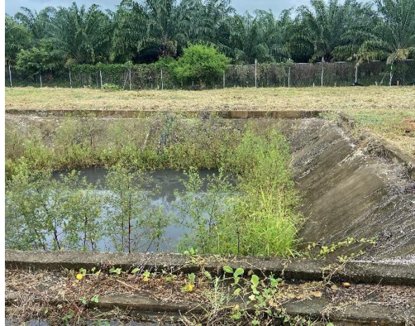
Facilidades sin dismantelar
