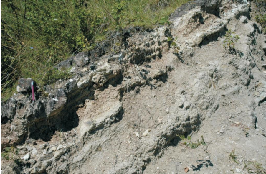
Figura 3.6 Lodolitas macizas interestratificadas con tobas de grano fino (parte superior). Sección de La Uribe. La longitud total de poligonal levantada con afloramiento es de 3.148,53 m.
