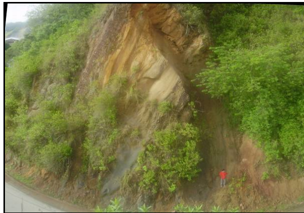
Figura 3-14. Intervalo de capas gruesas y muy gruesas de arenitas y conglomerados.
