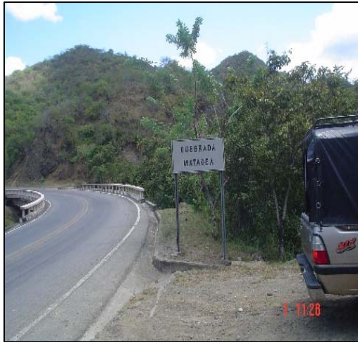
Foto 1. Cruce de la carretera Panamericana sobre la quebrada Matacea (Tomada hacia el norte)
