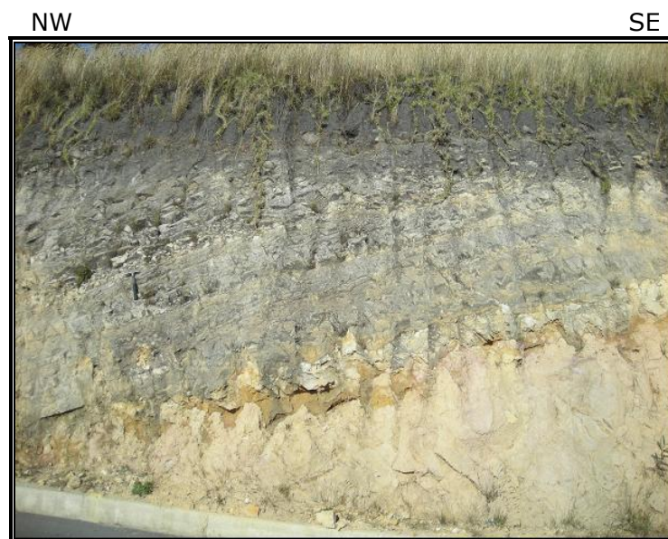
Foto R166. Estación R166: Afloramiento en la carretera Paipa- Palermo, se observan capas gruesas y lentiformes de arenitas de grano grueso en la base y capas medianas y lentiformes de cuarzoarenitas de grano fino hacia el tope. Formación Los Medios.
