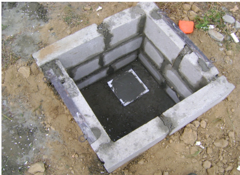
Figura 15. Caseta en adobe, tiene 80x80x60cm, tiene 40cm de profundidad y sobresale 20cm desde el suelo para que sea visible.
