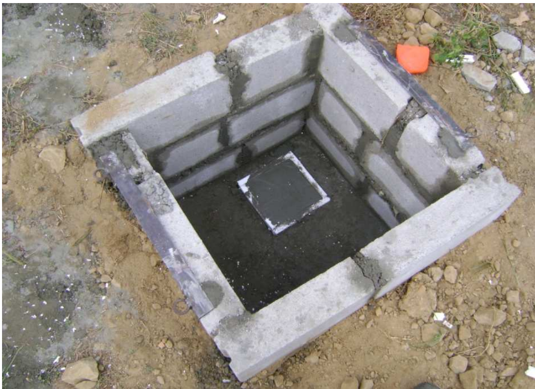
Figura 4. Caseta en adobe, tiene 80x80 cm de lado y 60cm de los cuales 40cm están en el subsuelo y sobresale 20cm.
