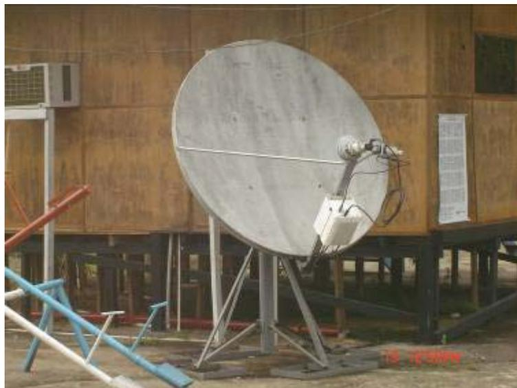
Fotografía 7 Antena Satelital para transmisión de datos.
