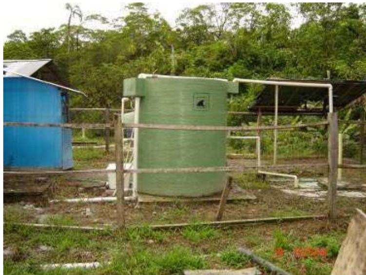
Fotografía 27 Planta integral para tratamiento de aguas residuales
