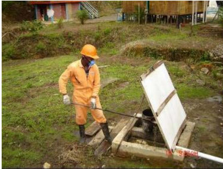
Fotografía 28 Mantenimiento de los sistemas de trampa de grasas en campo base
