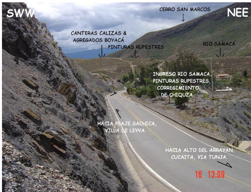
Figura 4. Vista panorámica de la vía principal Tunja-Villa de Leyva, 250 metros antes de la entrada por carretera destapada al Corregimiento de Chiquiza.
