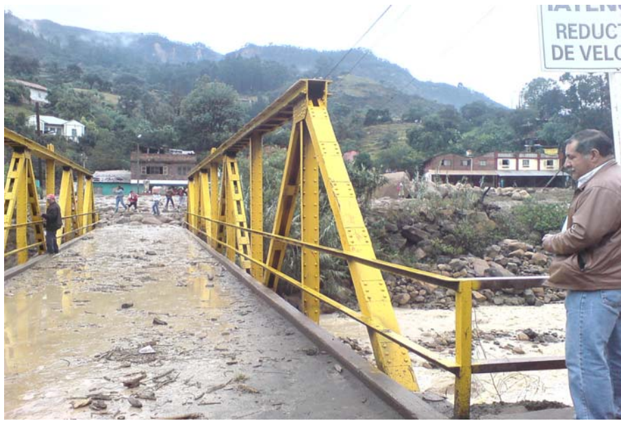
Figura 33. Puente sobre el Río Chicamocha en el Municipio de Paz del Río.
