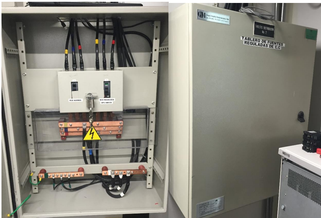
Imagen 10: Tablero de By Pass Manual de UPS 40 KVA - Distribución del CCP.
