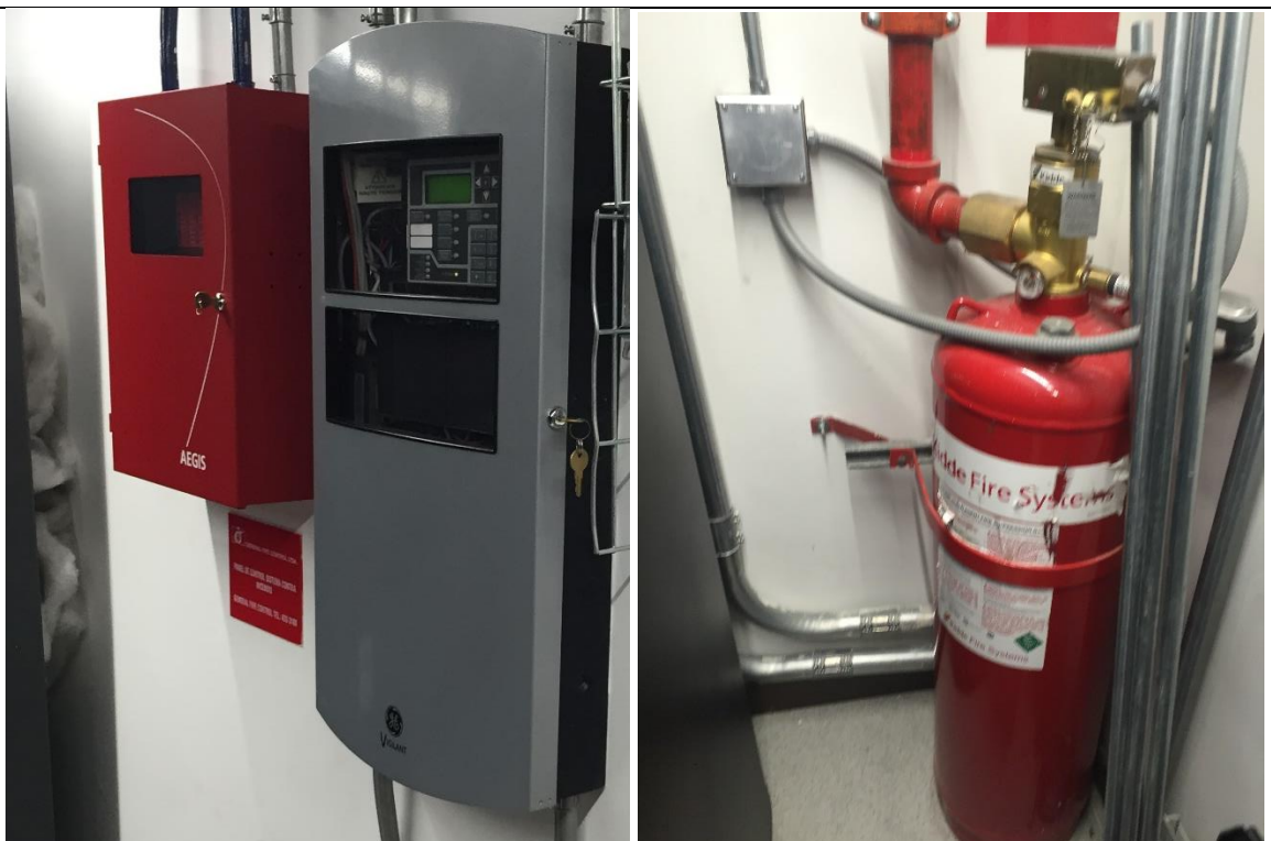
Imagen 9: Paneles y Cilindro con Agente Limpio del sistema de Detección y extinción de incendios del CCP.
